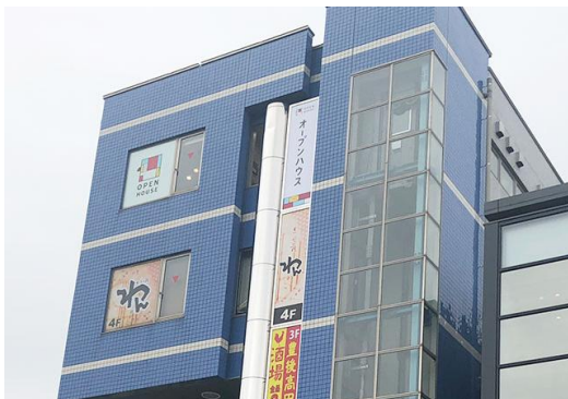
仙川営業センター
